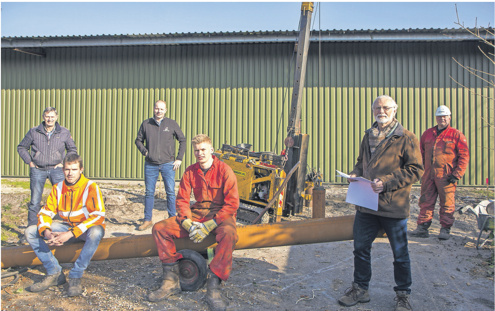
Vrijdag werd de eerste paal geslagen van het transformatiestation dat dinsdagmorgen werd geplaatst. Op het dak van Bijlsma B.V. realiseert men in de Trynwâlden een eigen zonnecentrale. Op de foto twee leden van Trynergie: Tseard van der Kooi (links) en Dick van der Duijn Schouten (rechts); in rode overall de medewerkers van Euro Funderingen Peter en Johan. Midden achter Frank Bijlsma en links voor zijn collega Remco Hielkema.
